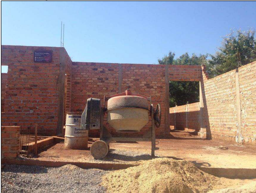
Figura 142 - Método construtivo de alvenaria convencional.
