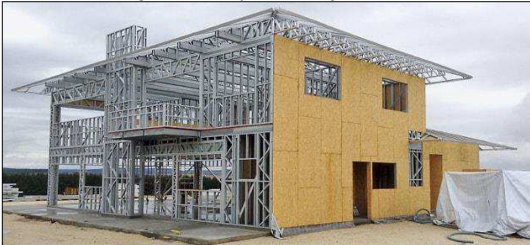
Figura 145 – Exemplo de construção em Steel Frame.
