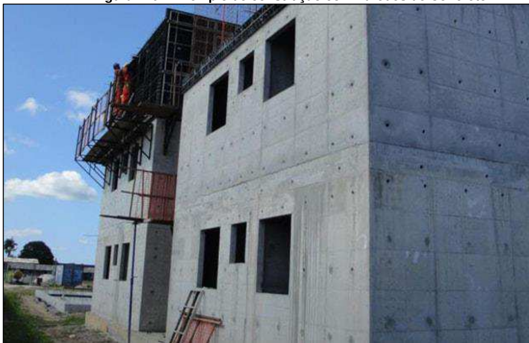
Figura 146 – Exemplo de construção com Paredes de Concreto.
