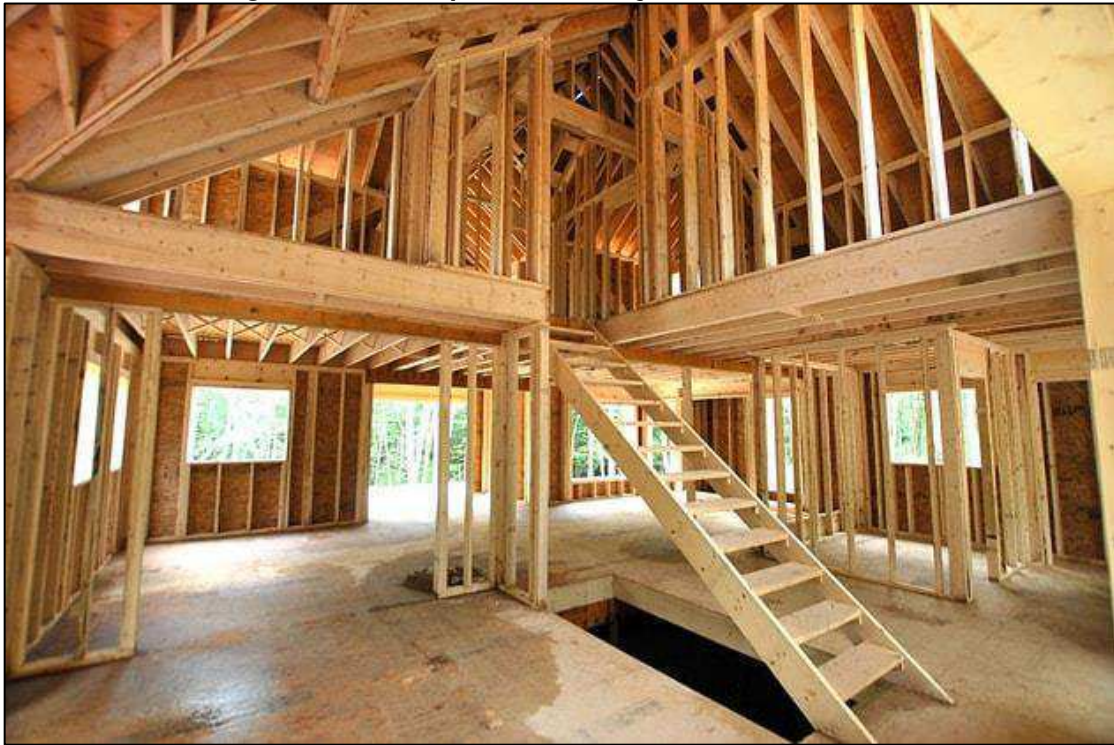
Figura 144 - Exemplo de construção em Wood Frame.
