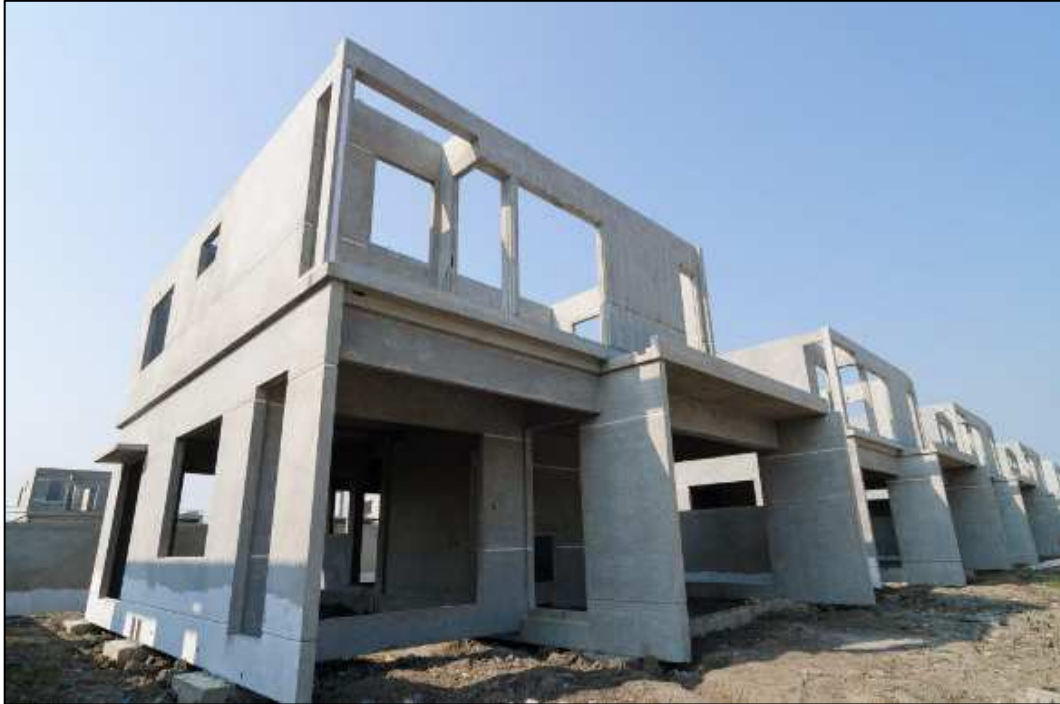
Figura 148 – Exemplo de construção em Concreto Pré-Moldado.
