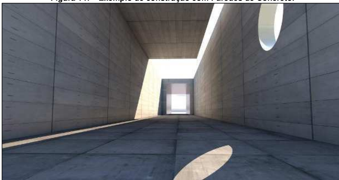
Figura 147 - Exemplo de construção com Paredes de Concreto.
